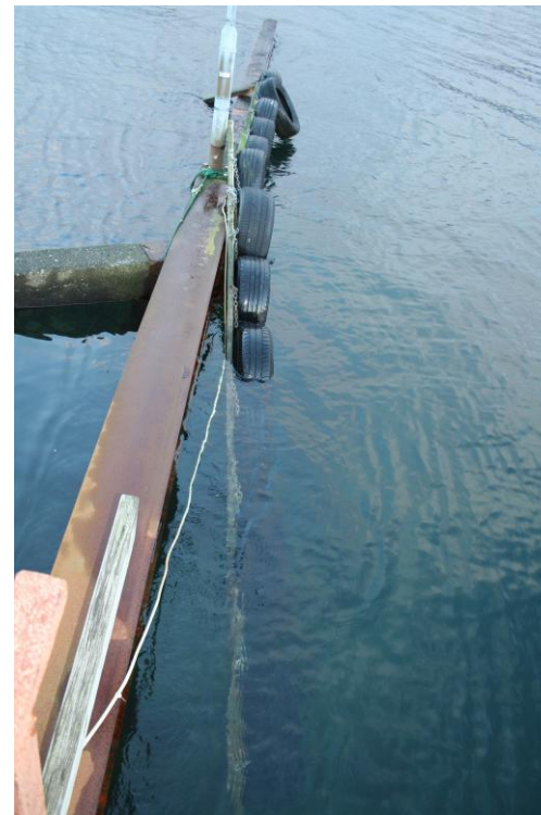
Fendring løsnet i stormen
