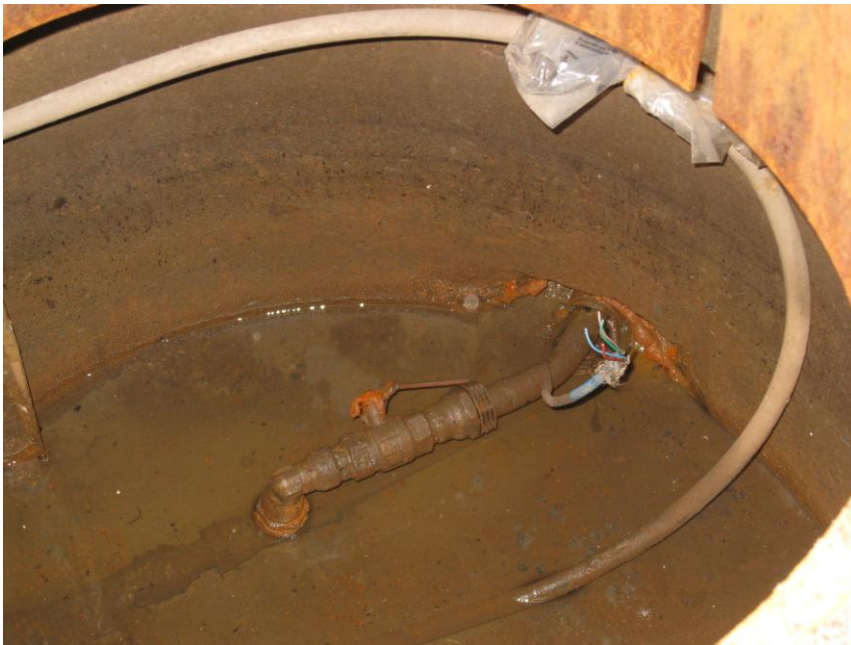
Vintervann. Varmekabel er defekt.
