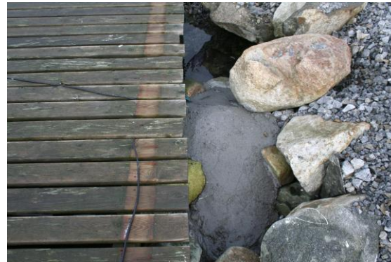
Øst brygge, rettet opp "telehiv" og støpt og sikret betongpeler
