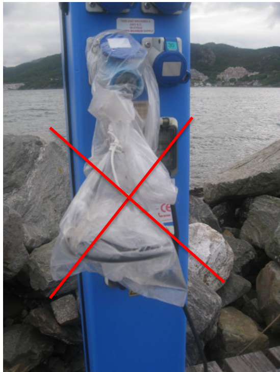
Denne posen blir full av vann
