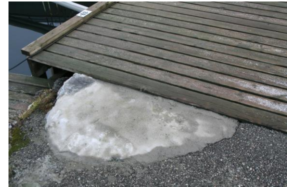
Støpt igjen utvasking i grunnen (3 plasser)
